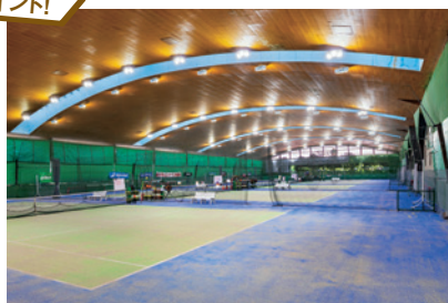
LED照明で明るく快適!
